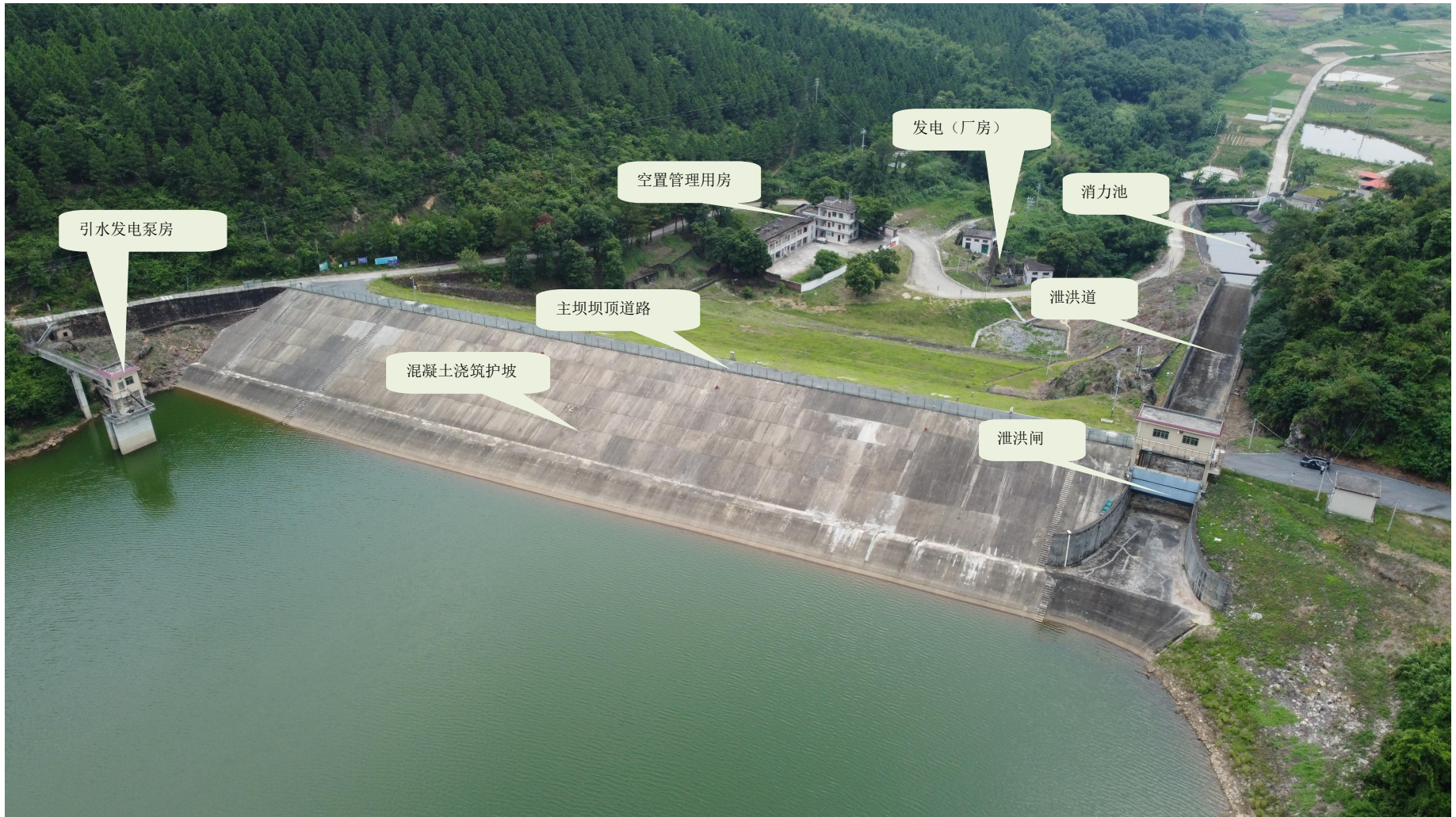
附图 4 主坝建设完成后平面图
